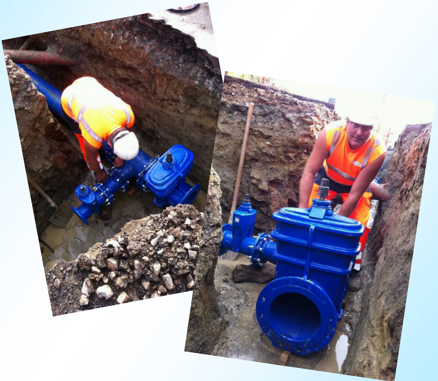
Pose d'un té Ø250/125 et d'une vanne Ø250 et Ø125
